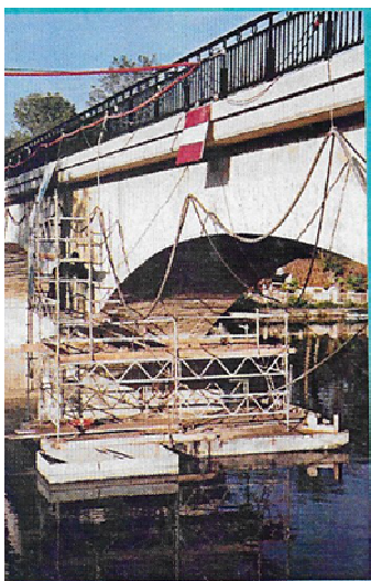
Rejointoiement des maçonneries
