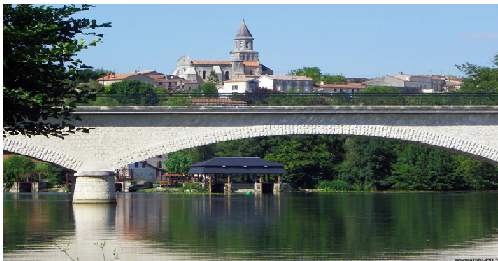
LE PONT DE MOSNAC A SAINT SIMEUX
