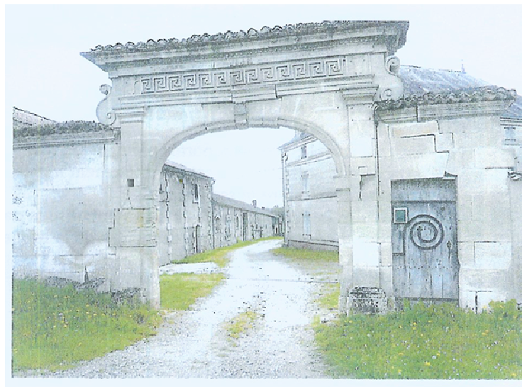
Portail avec porte charretière surbaissée dite « anse de panier » donnant plus de largeur à l'ouverture renforcée de pilastres, entablement néo classique, date de construction, noms du maître d'œuvre et du propriétaire
