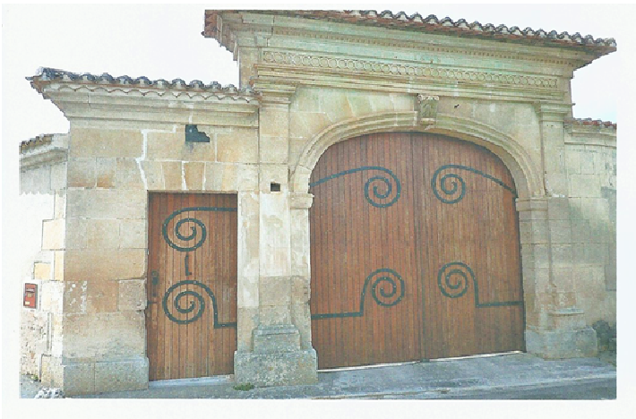
Portail avec porte charretière, corniche à billettes abritée sous des tuiles romaines, belles pentures assurant la solidité des vantaux de bois.
